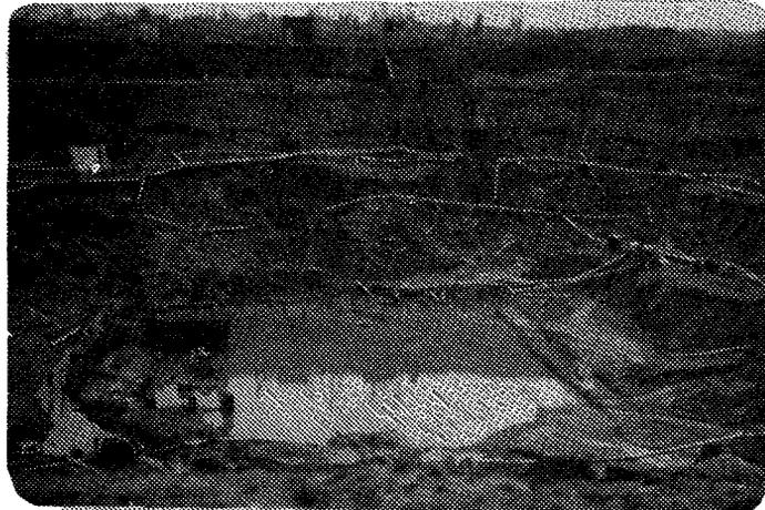
FIG 57. A VIEW OF THE EXCAVATED PIT FOR THE UNDER-GROUND POWER HOUSE ALONGWITH THE LOADING PLATFORM FOR IN-SITU LOAD TEST
