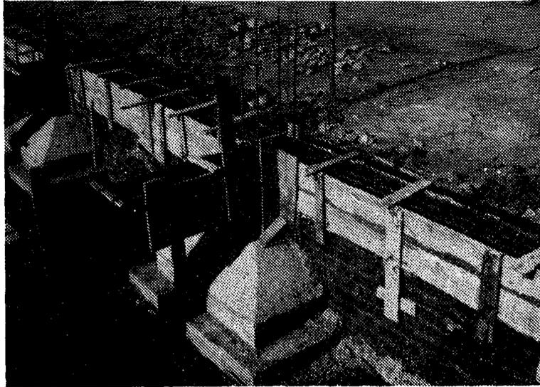
**FIG 20. CASTING OF THE PLINTH BEAM**
