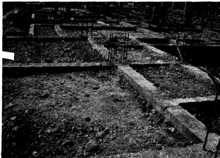
**FIG 22. EARTH FILLING UPTO THE PLINTH LEVEL**
