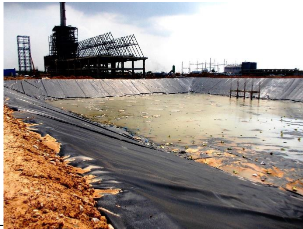
Fig. R-E-3(a): Geomembrane base
